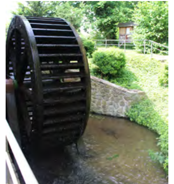
Reparatur des Wasserrades
