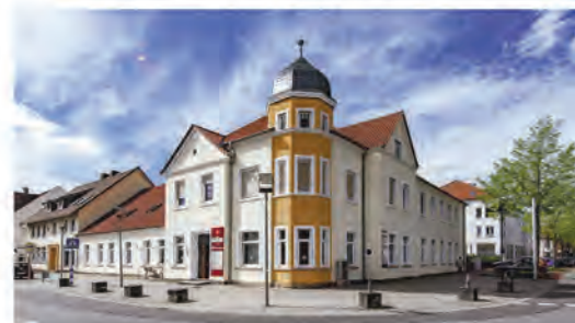
Der langjährige Klosterzimmermann Johann-Heinrich Schnirring baute 1909 beim „Linneboom“ das erste Bürgerhaus in Bersenbrück. Das seinerzeitige Hotel „Zum Lindenbaum“ hieß seit 1962 „Hotel Kreke“. Heute befinden sich neben Wohnräumen auch unsere Büroräume „Kanzlei am Markt“ in diesem Haus.
